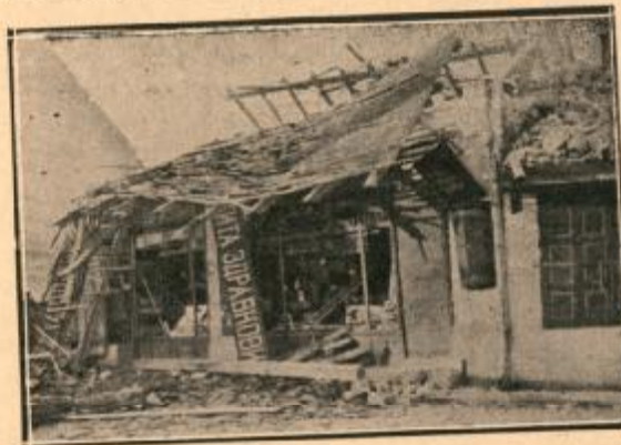
Порушене куће у улици Краља Александра приликом бомбардовања Београда 1915. год.
