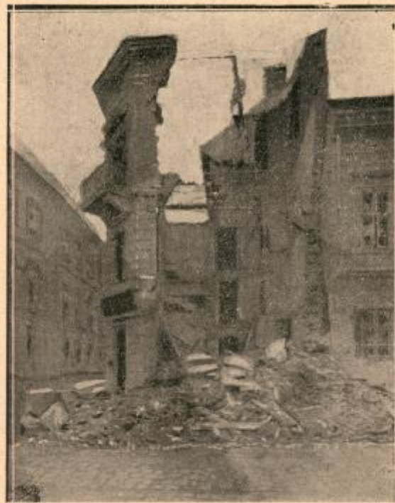
Порушена апотека „Спаситељ” на месту где је сада зграда Новог Университета.
