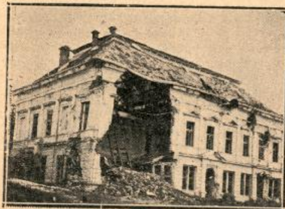
Порушена зграда у близини Калемегдана
