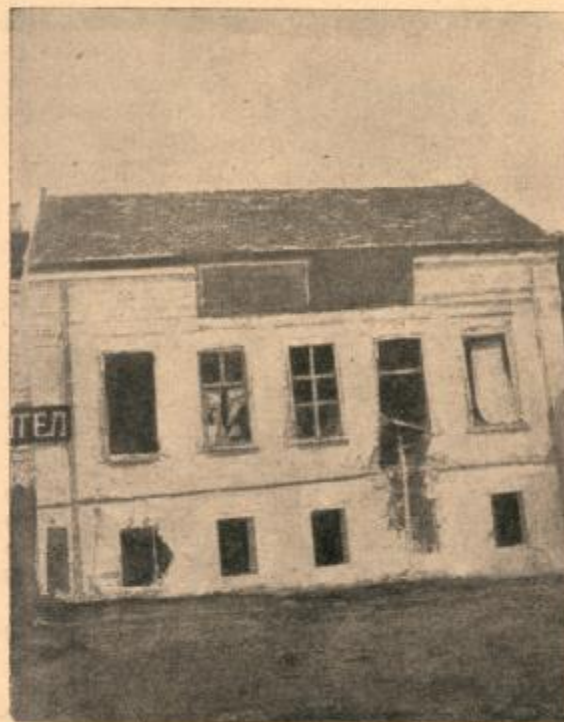
Порушена кућа на Кнез Михаиловом Венцу код Калемегдана.
